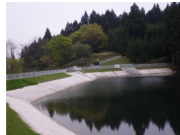
ため池の改修
