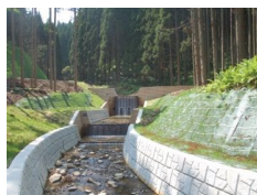
治山ダム・流路工事
